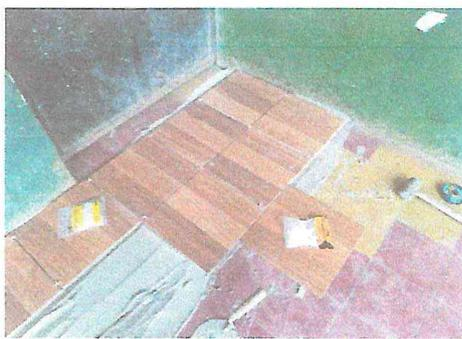
Foto 5: En esta fotografía se muestra el inicio de la colocación del piso cerámico en el corredor del módulo de la parte alta del establecimiento.
