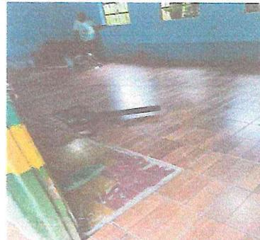
Foto 6: En esta fotografía se muestra la colocación del piso cerámico casi terminada en uno de los salones del módulo de la parte alta del establecimiento
