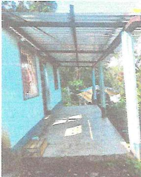
Foto 1: fotografía que muestra ya una parte colocada de lámina troquelada, la cual sustituyó la lámina antigua y en mal estado.
