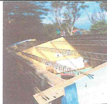
Foto 4: La fotografía muestra el avance del trabajo, en el cual casi se logra quitar toda la lámina, para dar paso a colocar la lámina troquelada.
